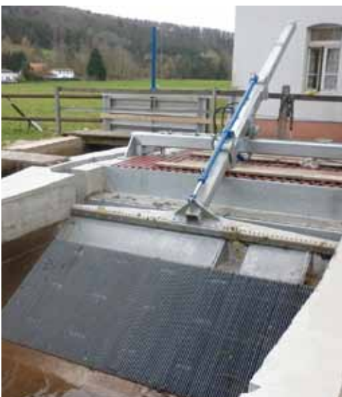
Abb. 4: Linearrechenreiniger in der Bauphase
