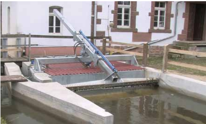
Abb. 5: Rechenreiniger nach Abschluss der Optimierungs- und Modernisierungsarbeiten
